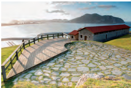
> Alojamiento de la Guarnición del Fuerte
